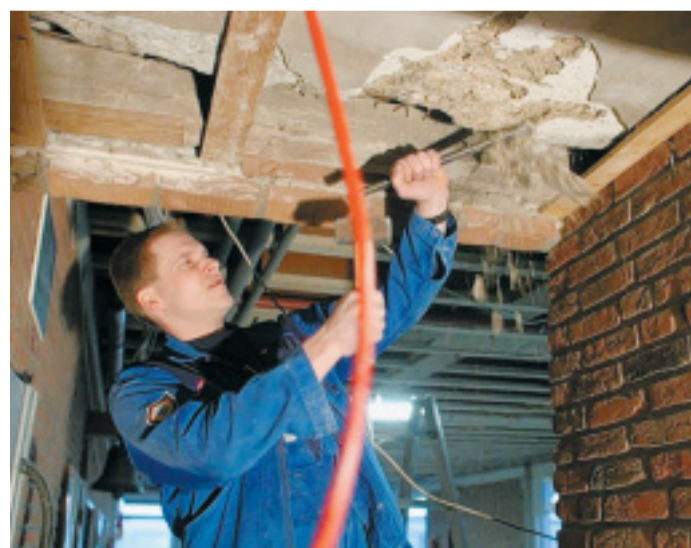
Es geht voran: Gas-Wasser-Installateur Heiko Tammen bei Stemmarbeiten im Erdgeschoss.
